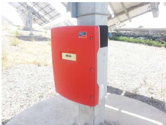
شکل ۲: اینورتر متصل به شبکه نیروگاه الهیه
