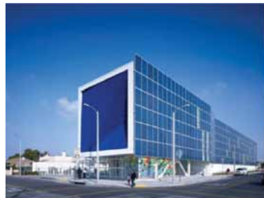
طراحی نمای یک دبیرستان با استفاده از ۶۵۰ پانل خورشیدی که در مجموع ۷۵٪ نیاز انرژی بنا را تامین می‌کند.
