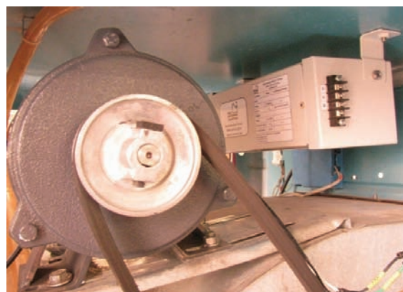
شکل ۱۸: نصب موتور ۵۵۰ وات در داخل کولر آبی
