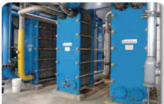
شکل ۶: مبدل صفحه‌ای برای استخراج حرارت آب پوسسته
